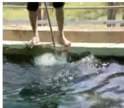
กวาดตะกอน
