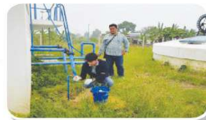
ท่อจ่ายน้ำ
