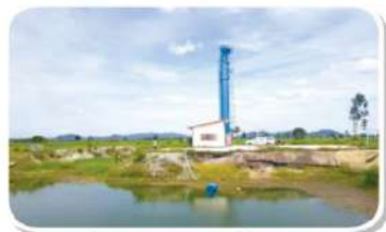
น้ำดิบ/โรงสูบน้ำดิบ/ เครื่องสูบน้ำ
