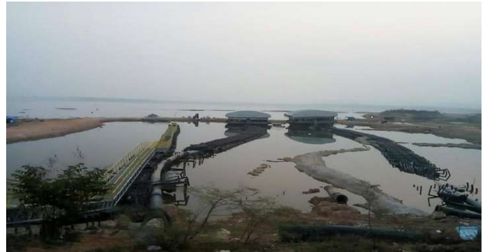
การสร้างคันกันน้ำเพื่อยกระดับแพสูบน้ำ
