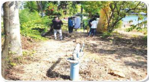
บ่อบาดาลและเครื่องสูบน้ำดิบ
