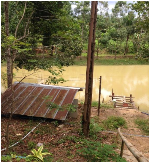
แหล่งน้ำใช้ในการเกษตรและหอถังสูงจ่ายน้ำ
