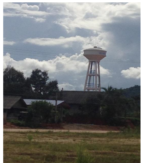
หอถังสูงของระบบประปา อบต.
