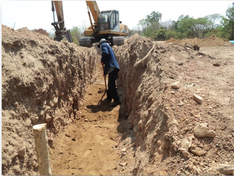
รูปการเตรียมพื้นที่สำหรับการวางท่อส่งน้ำ
